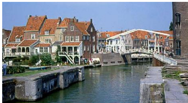
Enkhuyzen : Oude Haven (Vieux port) – Photos E. Debouny
